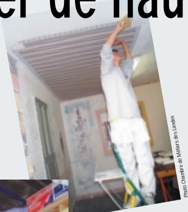
Sur un escabeau ou en équilibre instable sur un rack de stockage, le risque de chute ne doit pas être minimisé
